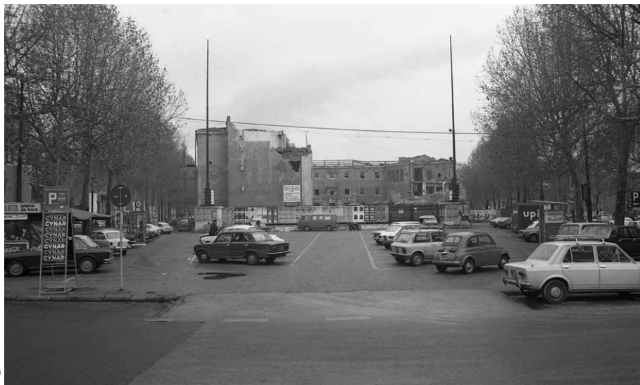
Fig. 1_Firenze, lavori di demolizione al Cinema Cristallo, 1975
