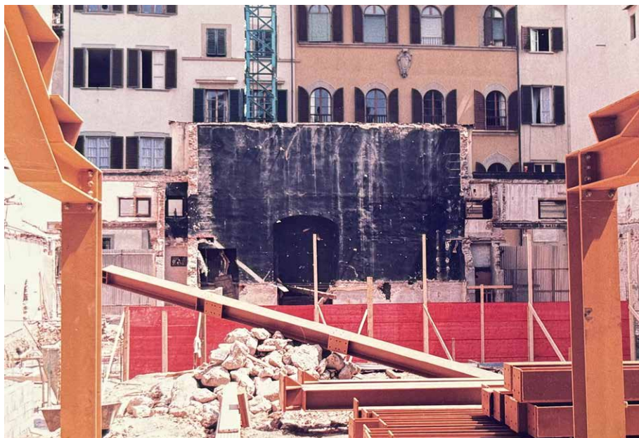
Fig. 1_ Cantiere nelle ex aree verdi di Palazzo Bastogi
