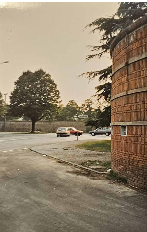
Fig. 7 _ Fotografia del muro perimetrale in relazione alle mura storiche della città
