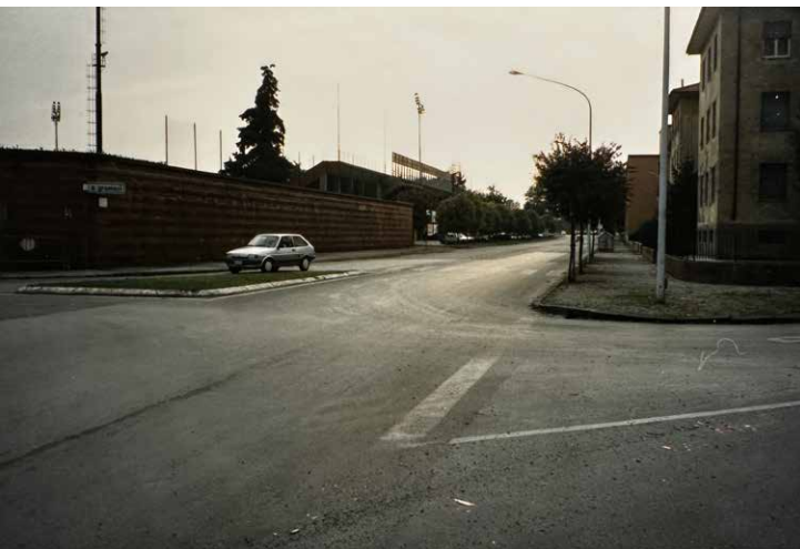
Fig. 10_Fotografia del muro di cinta dello Stadio
