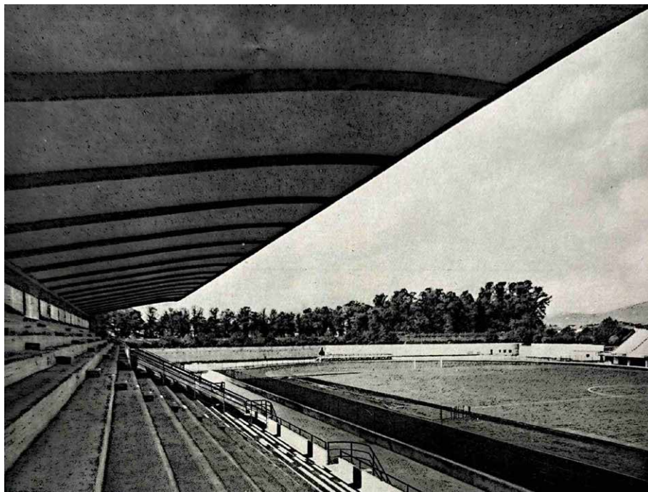
Fig. 1_Veduta del campo dalla tribuna coperta. All'intradosso è visibile il sistema strutturale. Sullo sfondo il muro di cinta dello Stadio in rapporto alle mura urbane con le sue alberature
