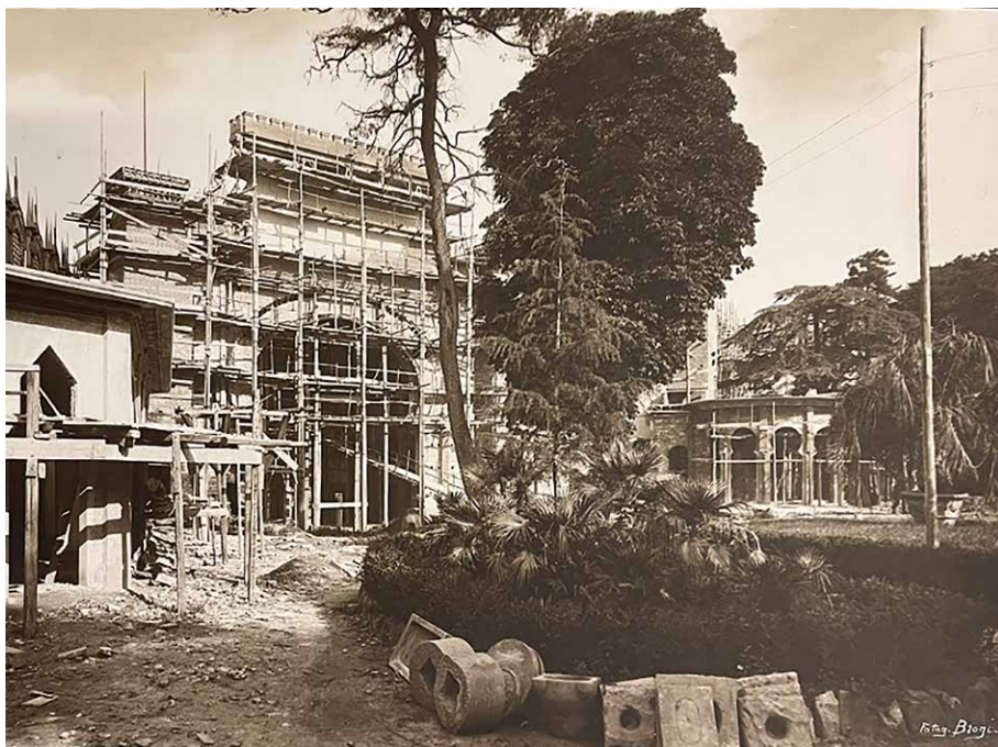
Fig. 3_ Teatro Giardino Alhambra in costruzione. Foto Brogi, 1921
