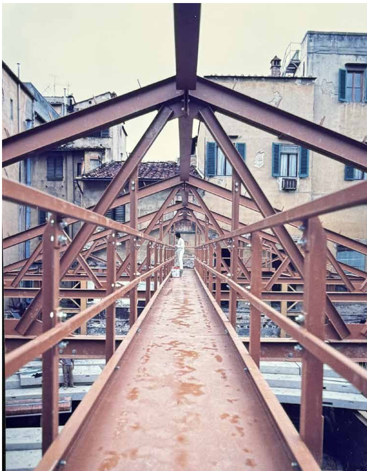
Fig. 2_Capriata metallica di copertura con il ponte tecnico per luci e regia
