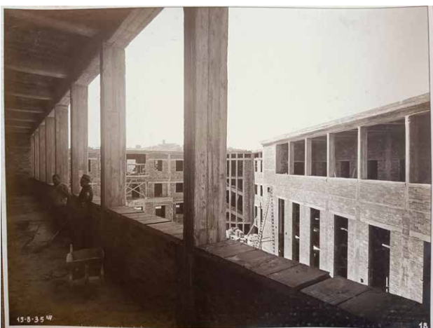
Figg. 13, 14_ Aurelio Cetica, Casa del Balilla in Firenze, Foto del cantiere
