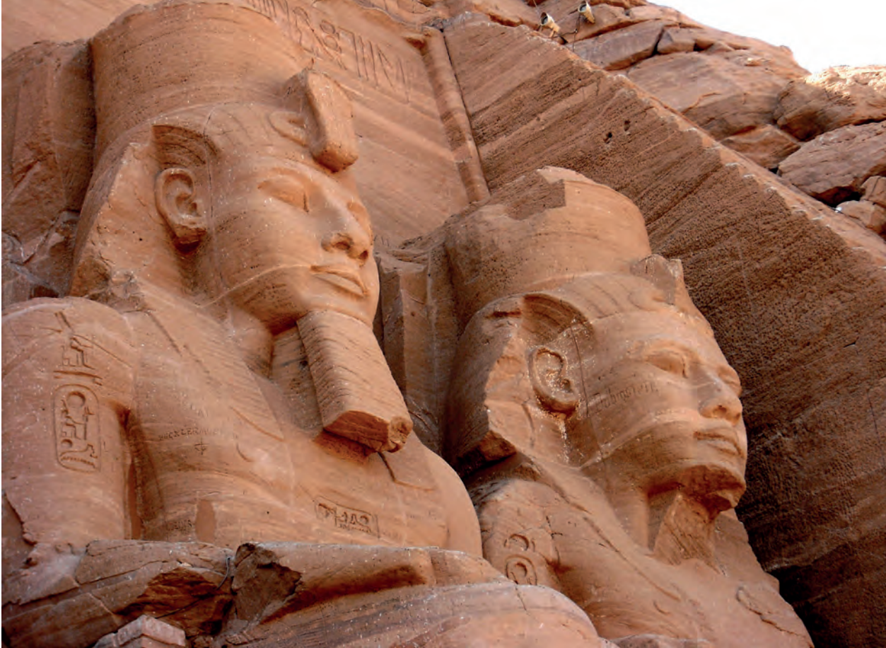
Particolare del tempio di Abū Simbel (2009). Sono evidenti i tagli per lo smontaggio del monumento e le iscrizioni storiche dei viaggiatori / Detail of the temple of Abū Simbel (2009). The cuts for dismantling the monument and historical inscriptions made by travellers are visible (© Chiara Matteini)
