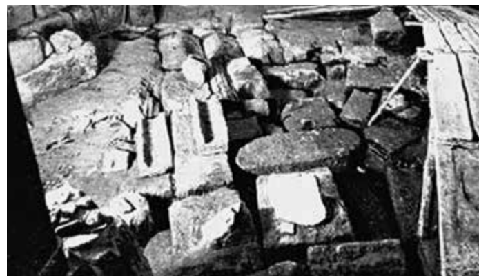
4a-b. Fotografie della platea di fondazione dell'ottangono di Sant'Aquilino messa in luce durante gli scavi del 1911
