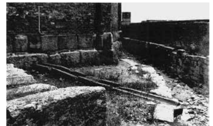
6. Canaletta passante nelle fondazioni dell'ottagono, documentata nell'esterno del lato nord-occidentale
