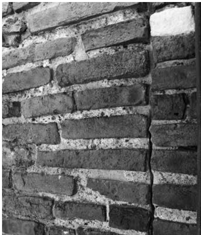
13. Giunto rettilineo tra l'ala di raccordo del tetraconco (a sinistra) e il perimetrale dell'atrio di Sant'Aquilino (a destra); fronte occidentale alla quota dei finestroni
