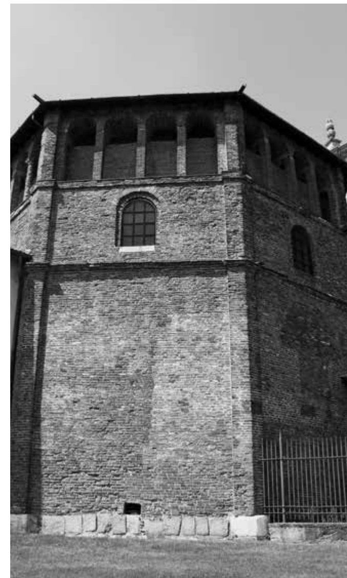
18. Vista da est del sistema di coronamento del tetto di Sant'Aquilino
