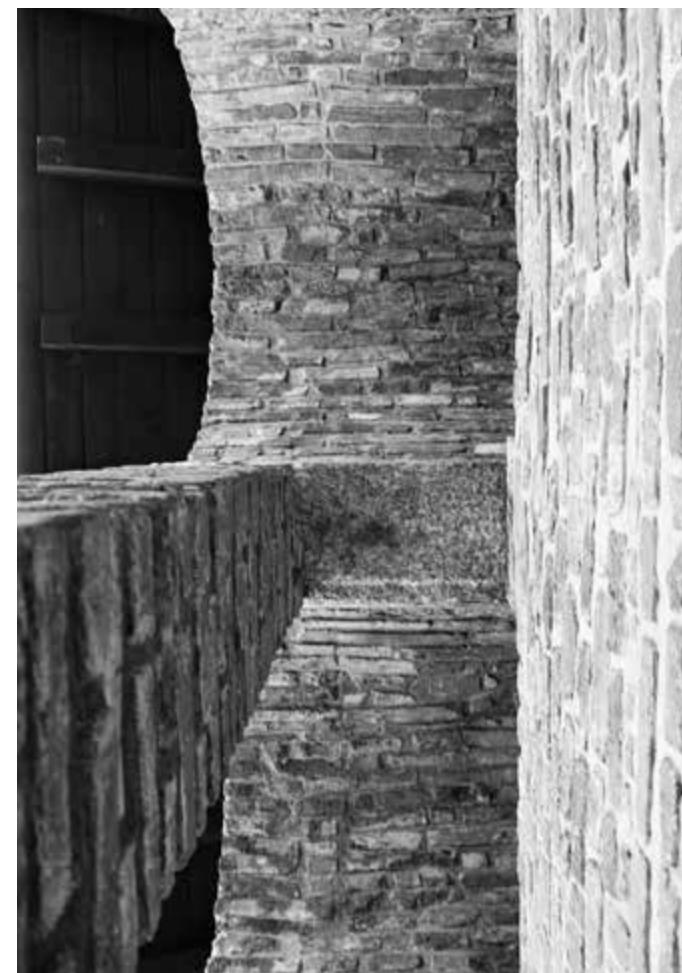
20. Impiego di laterizi con dimensioni differenziate e tegole nelle voltine del loggiato del mausoleo.
