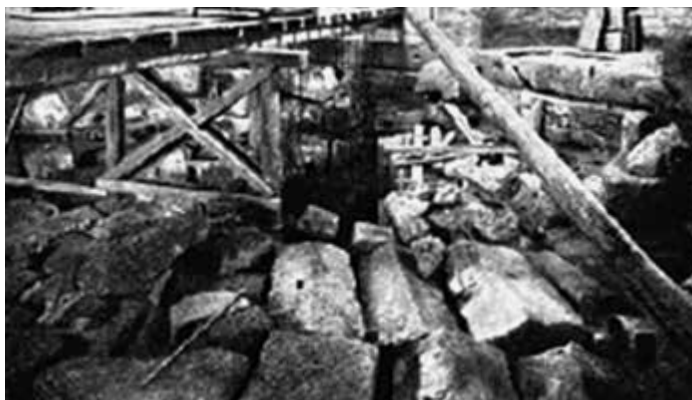
4a-b. Fotografie della platea di fondazione dell'ottangono di Sant'Aquilino messa in luce durante gli scavi del 1911
