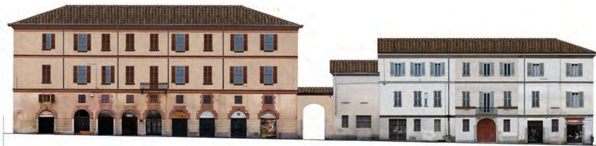
Prospetto Nord di Corso Garibaldi (da via Luigi Porta a via Villa Glori)
