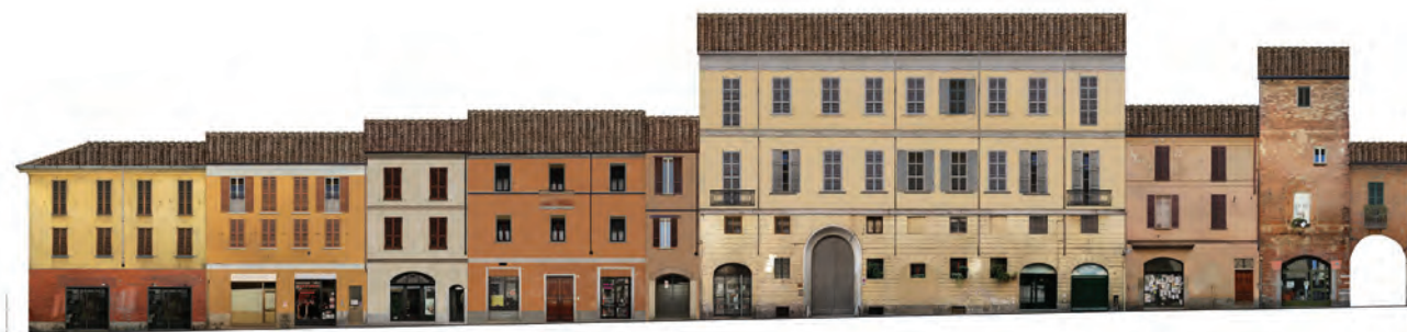
Prospetto Sud di Corso Garibaldi
