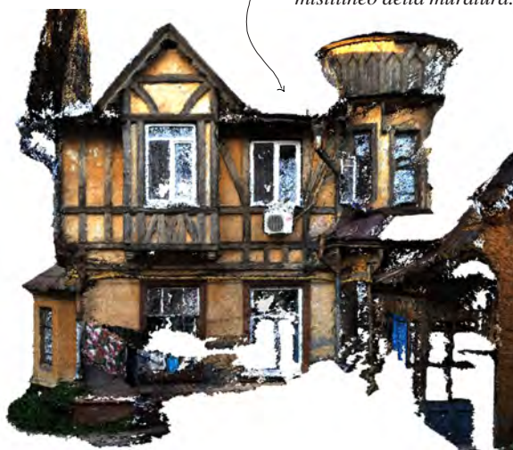
Le misure del rilievo diretto verificano l'efficacia e l'affidabilità dell'andamento mistilineo della muratura.
