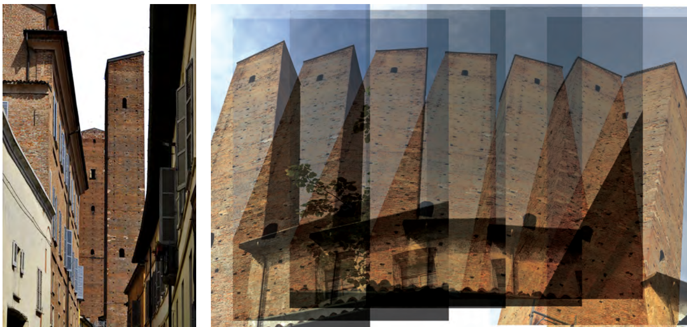
Serie di fotografie statiche di uno stesso elemento architettonico acquisito in movimento. Il principio del movimento attorno ad un elemento architettonico è il medesimo utilizzato per la metodologia di rilevamento tramite acquisizione fotografica tridimensionale da molteplici punti di vista.
