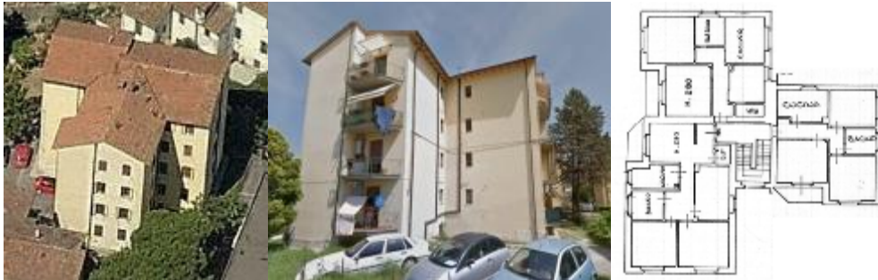
Figura 4-55 – Esempio di edificio collocato in Via Castel de Guidi
