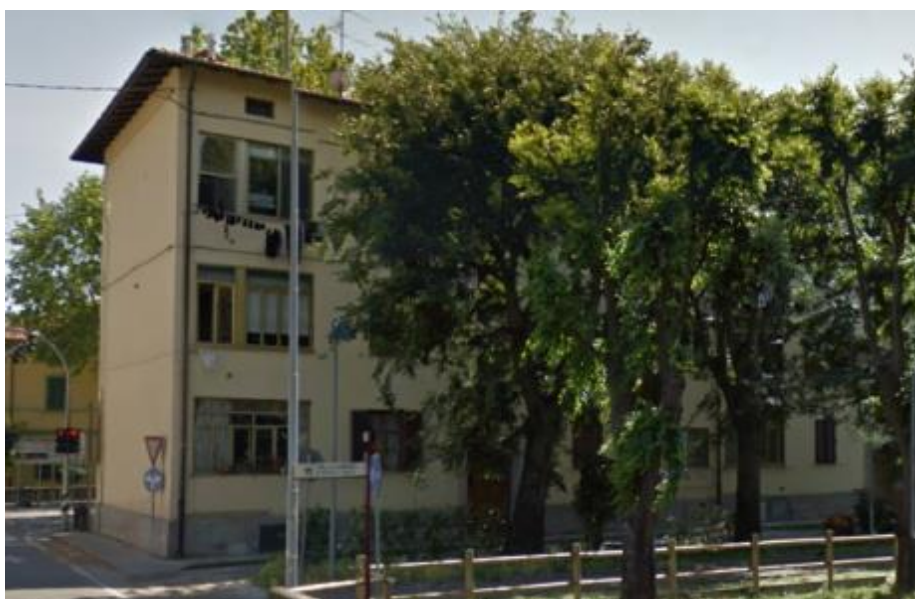
Figura 4-66 – Esempio di edificio le cui logge sono state chiuse successivamente alla costruzione formando delle verande
