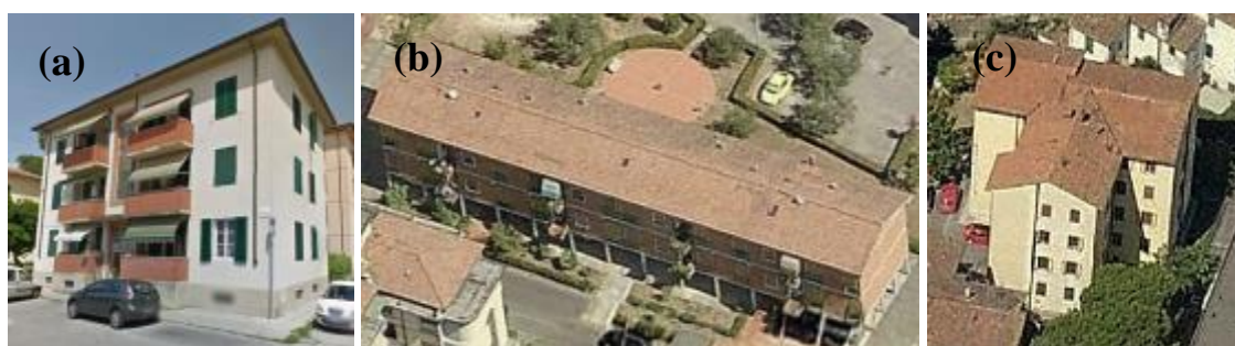
Figura 4-60 - Esempi di tipologie a “casa in linea isolata” (a), “casa in linea continua” (b), “palazzina” (c)
