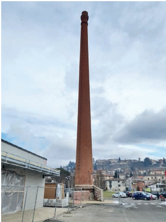
Figura 1. Struttura oggetto di studio (vista S-W).
