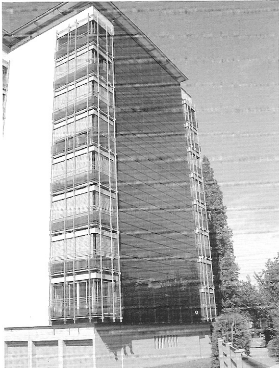
Fig.1 Stazione di Friburgo, facciata fotovoltaica integrata in policristallino
