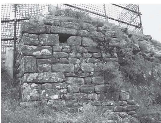
Tav. XXXVII La buca strutturale 1 La buca strutturale realizzata nella parete fondale sud della torre orientale, funzionale all'alloggio del solaio ligneo dell'ambiente interrato ricavato nell'area sud del castello.
