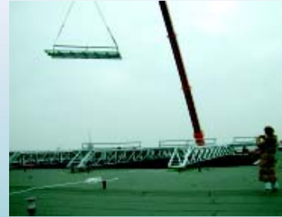
Alcune fasi durante il montaggio dell'impianto
