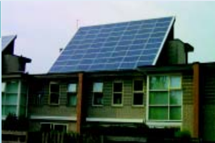
Fig. 10 Edifici residenziali ad Amersfoort in Olanda.
