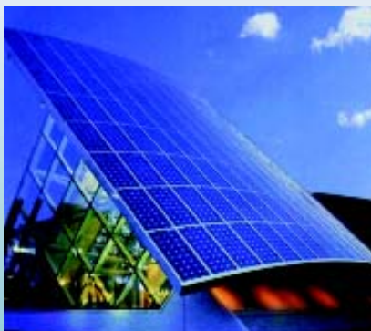
Fig. 15. Edificio per esposizioni, BP Solar
