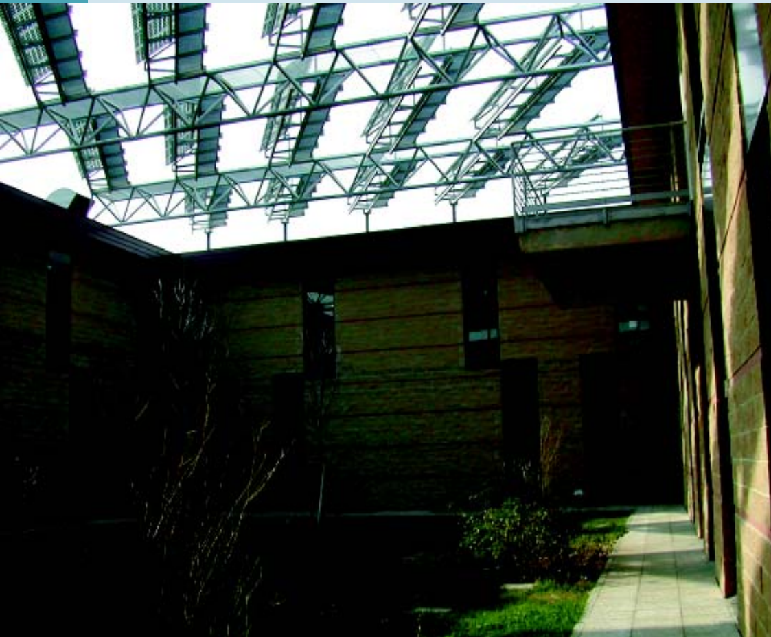
Interno della corte con l'impianto fotovoltaico ultimato
