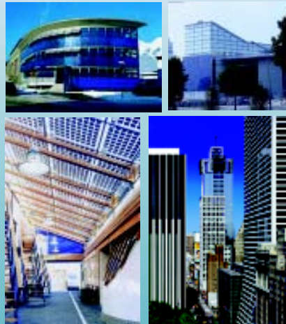
Fig.1-2, edifici per uffici in Germania
