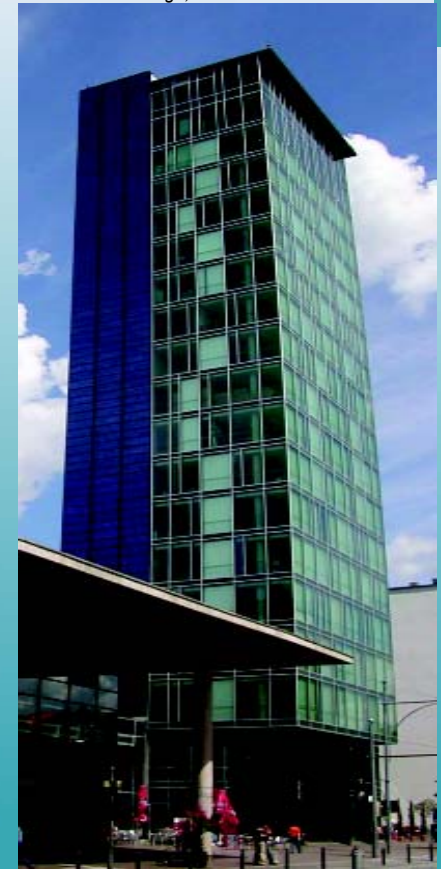
Stazione di Friburgo, facciata fotovoltaica
