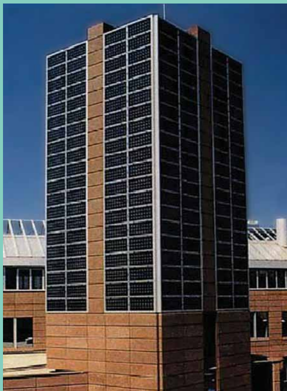
Azienda elettrica a Pirnanses, Germania (foto: I Hagemann). La stessa struttura della facciata ventilata in "cotto" supporta i moduli fotovoltaici di tipo standard, che garantiscono una buona tenuta agli agenti atmosferici, continuità dello strato ventilazione e produttività di energia.
