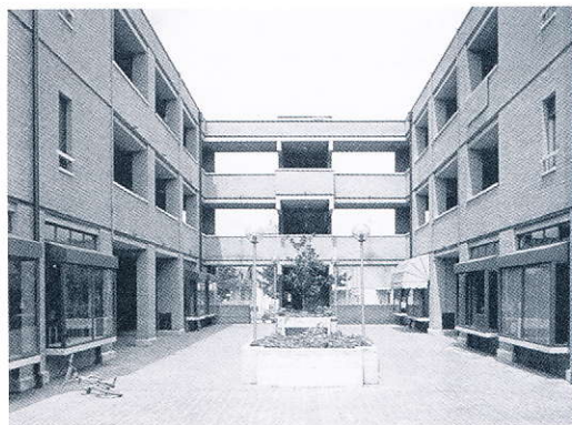
Enea Manfredini (con A. e G. Manfredini), quartiere Betulla 21, Reggio Emilia, 1980: veduta della corte interna di un edificio con distribuzione a ballatoi.
