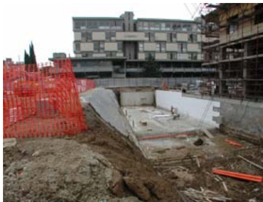
I lavori in corso per il primo stralcio esecutivo dei parcheggi interrati
